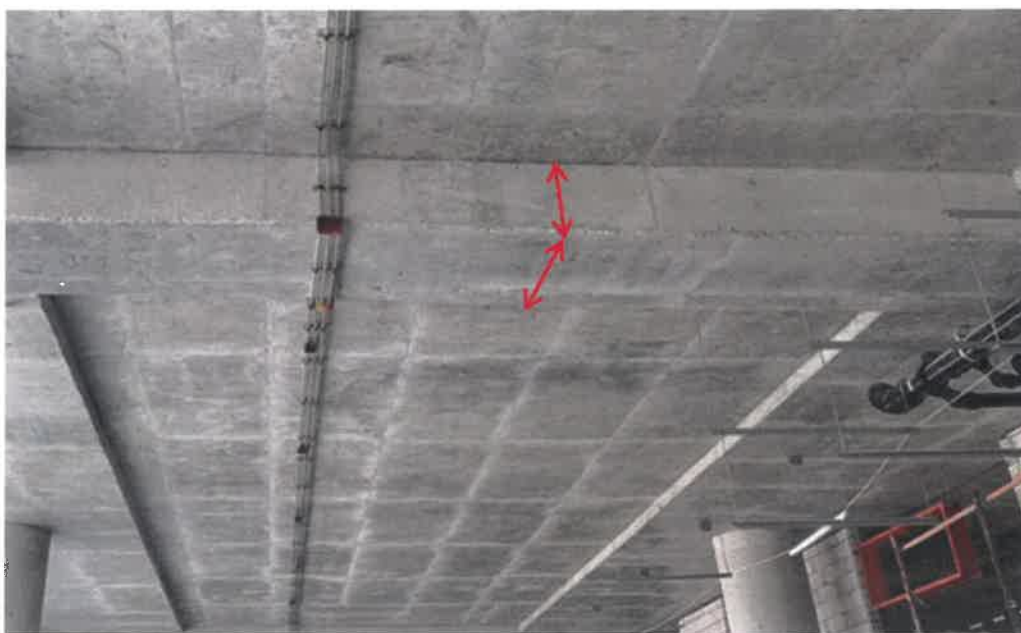
ภาพที่ 6 เก็บข้อมูลขนาดของโครงสร้างคานตรวจสอบกับแบบก่อสร้าง
