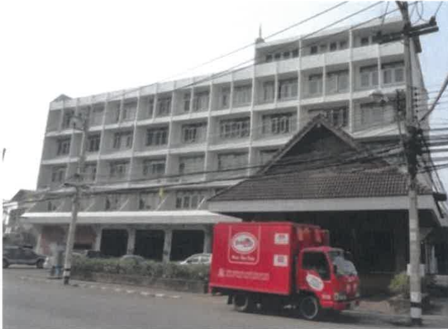
ภาพที่ 3 อาคารเดิมก่อนปรับปรุง
